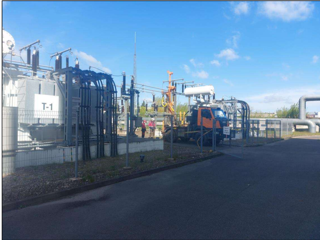
Pav. 6 Gręžimo agregatas tyrimų taške (aut. inž. geol.)
