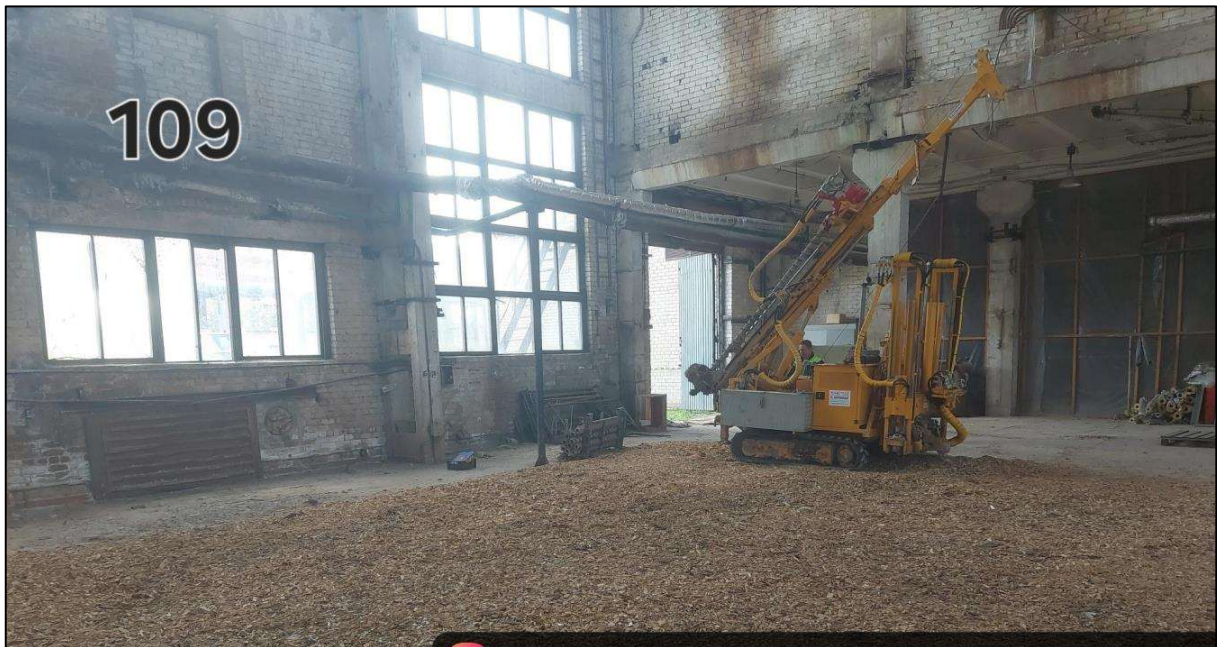
Pav. 7 Gręžimo agregatas tyrimų taške (aut. inž. geol.)
